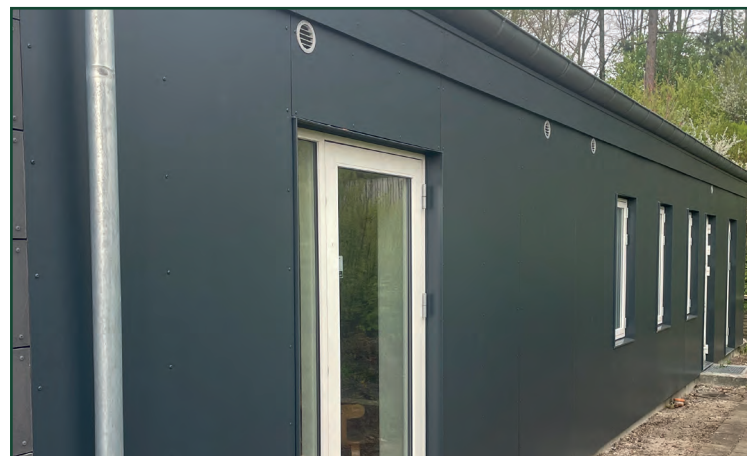
Billede 4: Ny let facadebeklædning af modstandsdygtig kompaktlaminat.
