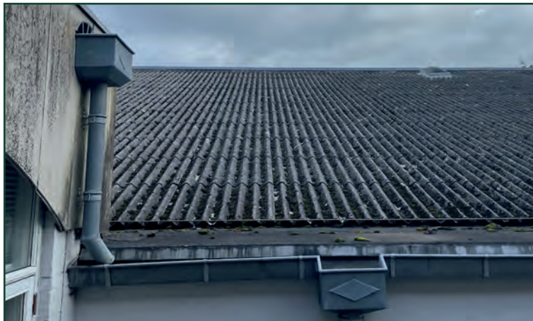
Billede 2: Sammenbygning med hal 2 (bølgepladetag udskiftet i 2024).
