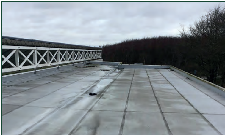
Billede 1: Tagmembran med vandfyldte lunger.
