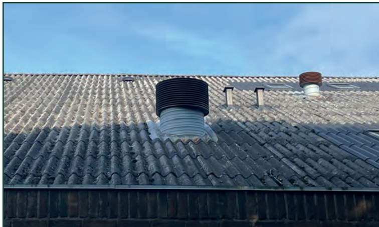
Billede 3: Gennembrydninger i tagfladen.
