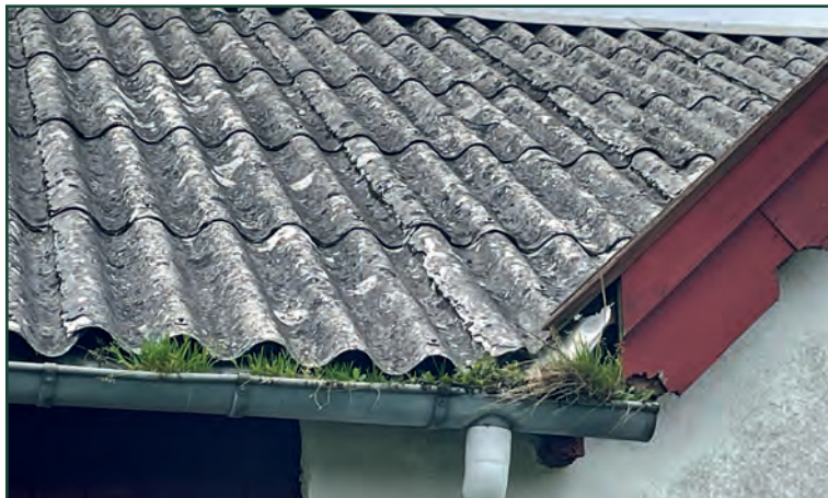
Billede 1: Fyldte tagrender = manglende vedligehold.
