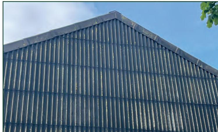
Billede 4: Bølgeplader på gavl.
