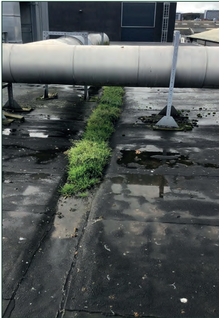
Billede 1: Gennembrydninger i tagfladen.
