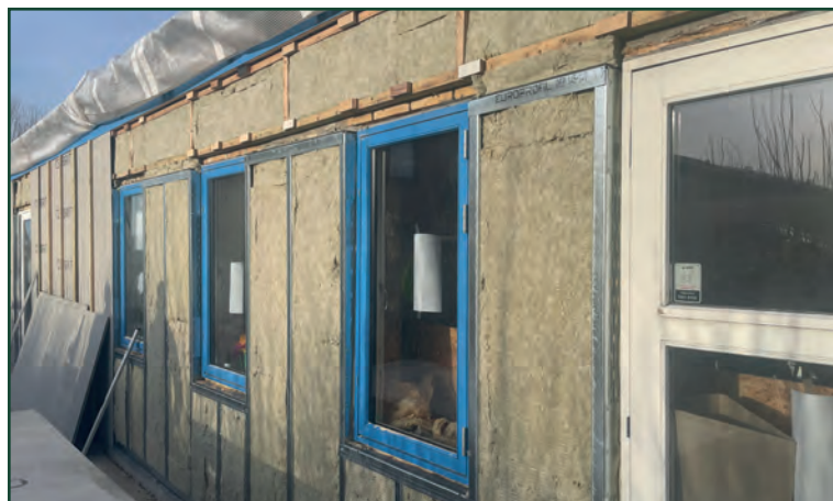
Billede 3: Efterisolering af ydervæg.
