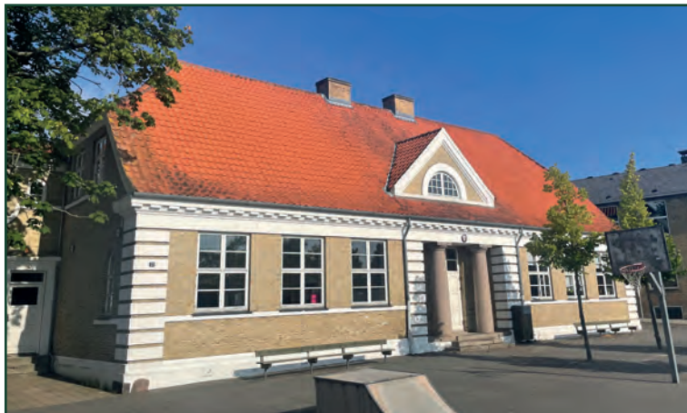
Billede 1: Flot bygning, men taget er utæt.
