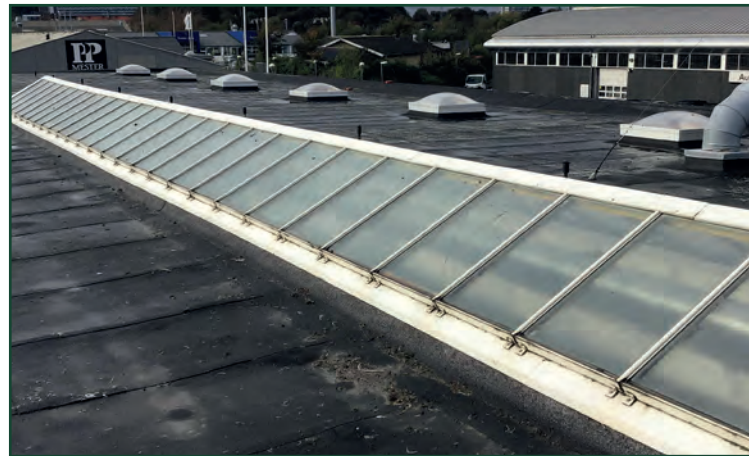
Billede 3: Bølgeplader på gavl.
