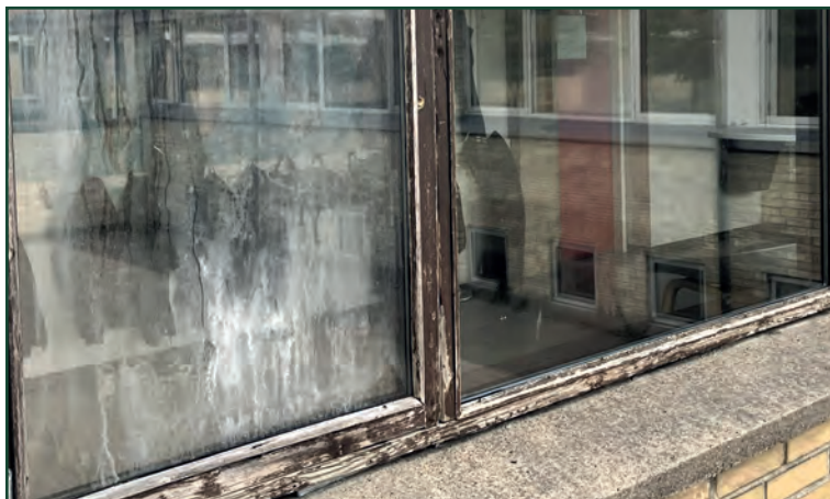
Billede 3: Punkterede ruder og slidte trævinduer.
