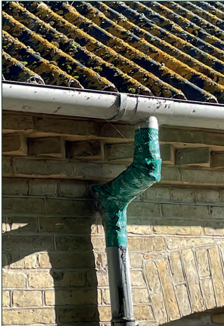
Billede 1: Tætning af nedløbsrør med tape.
