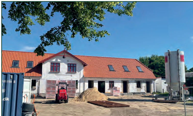
Billede 1: Dallvej 5 under energirenovering.
