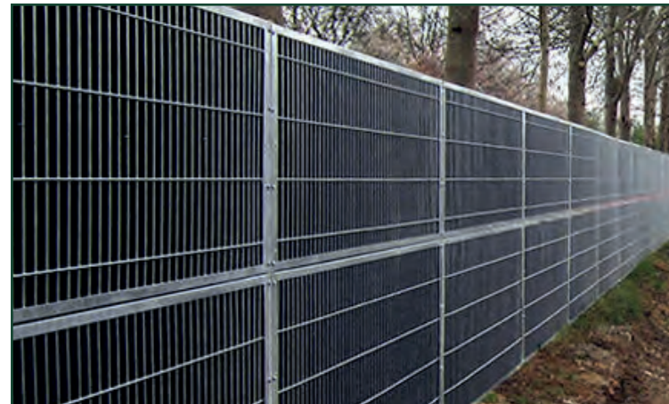
Billede 4: Hegn, hvor der er stillet krav til lyddæmpning.
