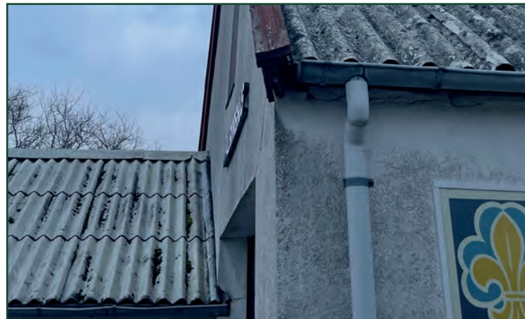
Billede 2: Sternbeklædningen er udtjent.
