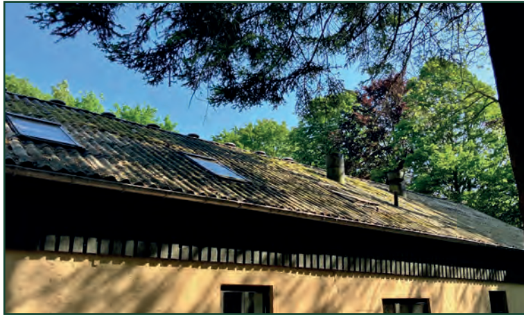
Billede 1: Vinduespartier er ældre dato.
