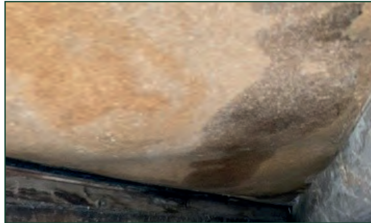
Billede 4: Tydeligt opfugtet undertag.
