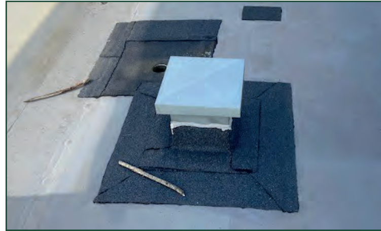
Billede 2: Reparation omkring taggennemføring.
